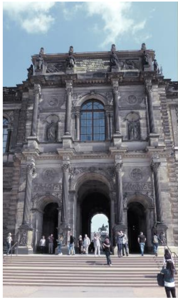
Zwinger - Semperegalerie vom Innenhof
